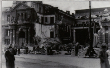
Dworzec kolejowy we Lwowie zniszczony przez Luftwaffe
