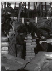
Żołnierze 10 Pułku Strzelców Konnych w czasie budowy schronu przeciwnocnego
